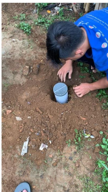
Gambar 8 : Pembuatan Lubang Biopori
