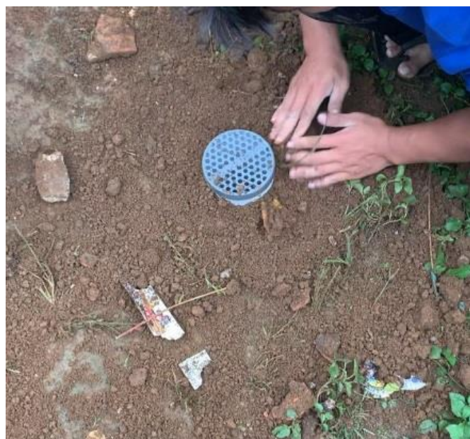
Gambar 8 : Pembuatan Lubang Biopori
